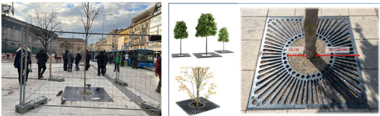
3) Yangi ekilgan daraxt ko'chatlari tanasidan beton plitka yoki asfalt yotqizmalariga qadar bo'lgan masofa 1,2 metr, ko'chat tanasidan har tomonga himoya temir panjaragacha bo'lgan masofa 60 sm dan iborat.
