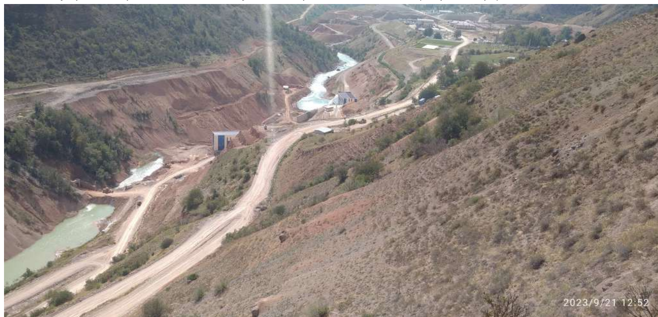
Расм. Пском дарёси ўзанида дамба қурилиши ва сувнинг тунел орқали ўтказилиш жойи.
